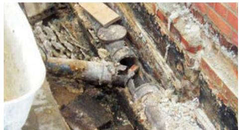
Die freigelegte Abflussleitung war auf der gesamten Länge verrottet und muss erneuert werden. In diesem Zusammenhang hat der Kirchenvorstand entschieden, dass in diesem Abschnitt auch eine Feuchtigkeitsdämmung der Außenmauer erfolgt.
